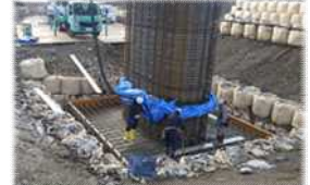
橋梁の耐震補強工事
